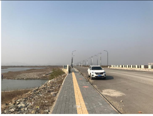
项目北侧现状道路
