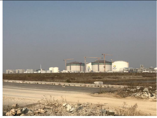
项目北侧(新奥LNG)
